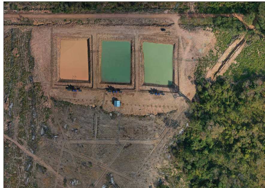
完成した溜池三基（容量6,000m 3 ）40m×50m深さ4m
